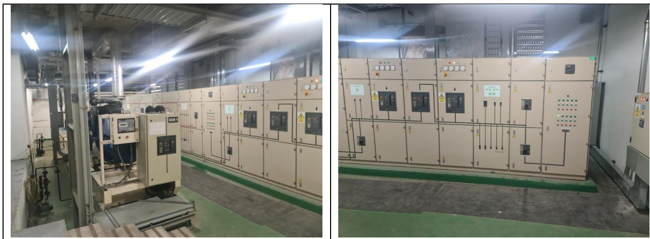
รูปที่ 2-15 ห้องเครื่องกำเนิดไฟฟ้าสำรอง
